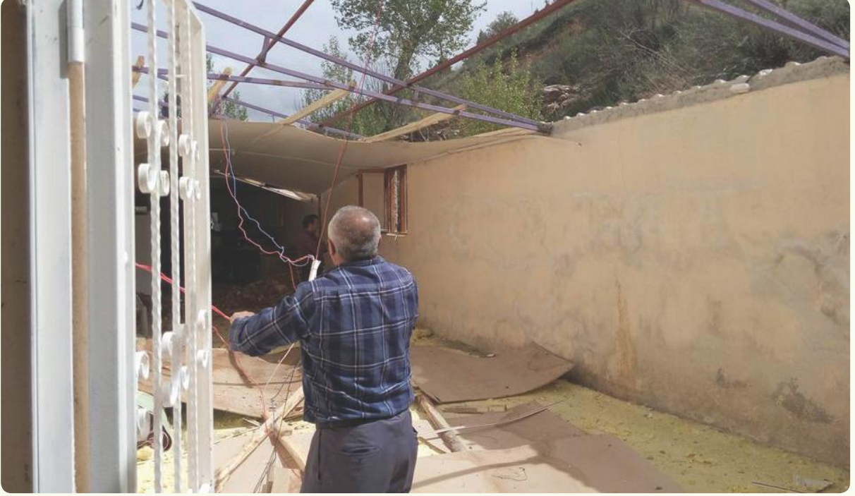
Mutfak Tadilatı Yapılırken
